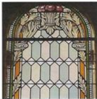
Verglasungsabschluß im Rundbogen der Bahn a (s III)
